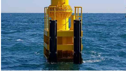
2-6 (4)점안시설 안전난간 설치
