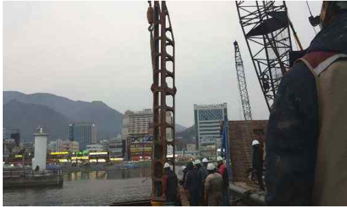
2-5 (13)동재하시험 _ 항타기 설치
